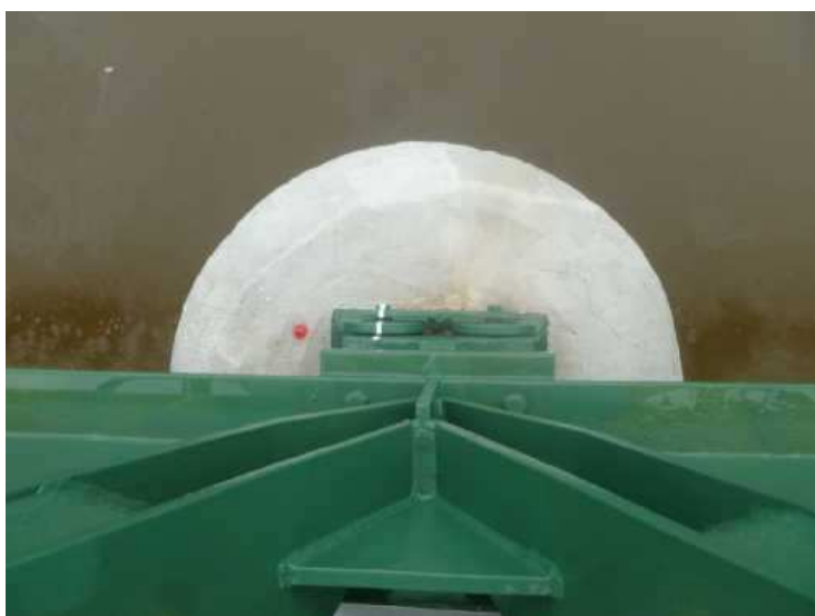
Pro ověření stavu a polohy ložisek byla ložiska označena bílým pruhem. Pro sledování stability pilířů byly využity geodetické metody a měření bodů na horním líci pilířů.
