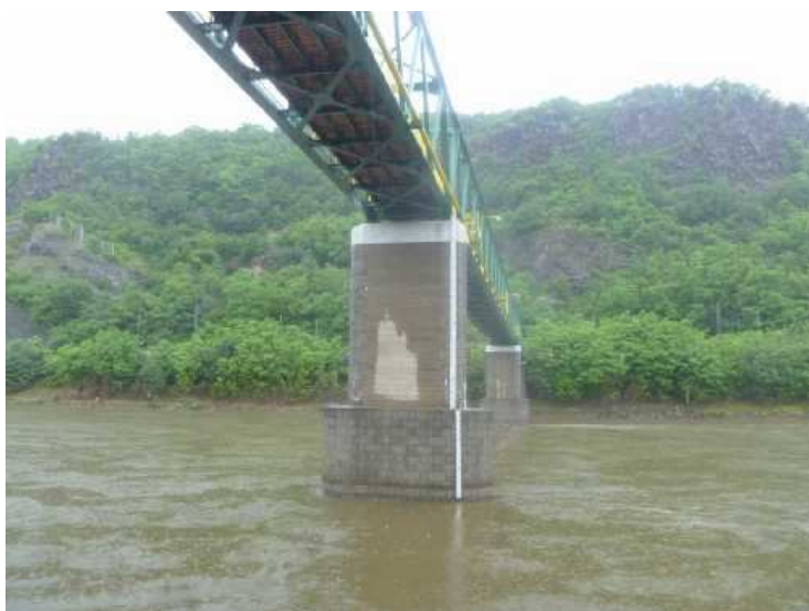
Pohled na na pilíř 3.
