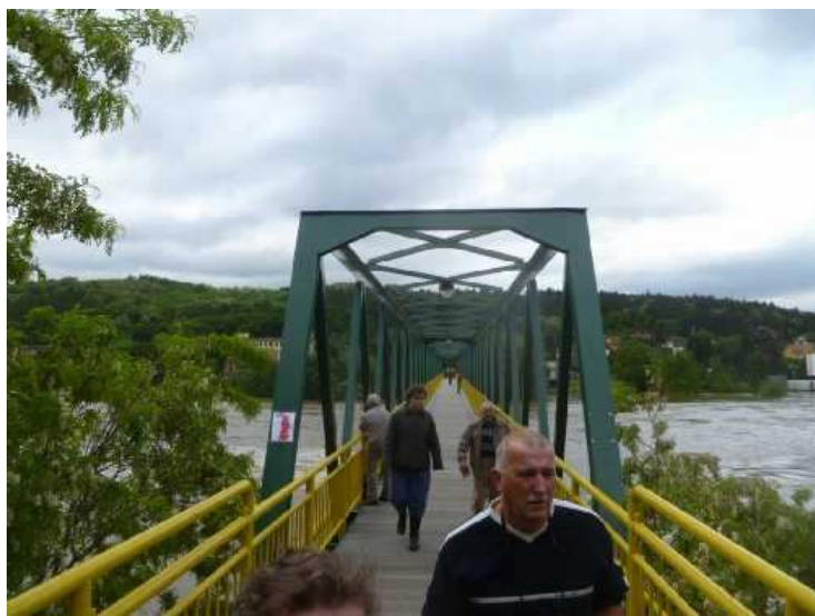
Provoz na lávce v době kulminace Vltavy dne 04.06.2013.
