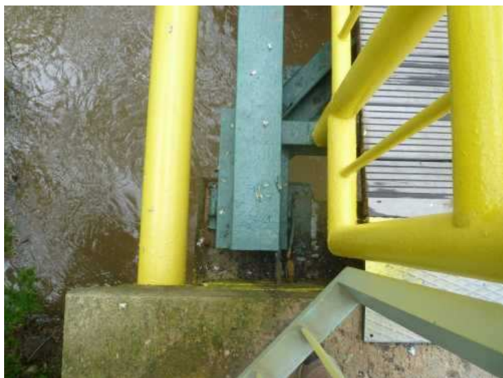
Uložení NK na opěře 6 v době kulminace Vltavy dne 04.06.2013.
