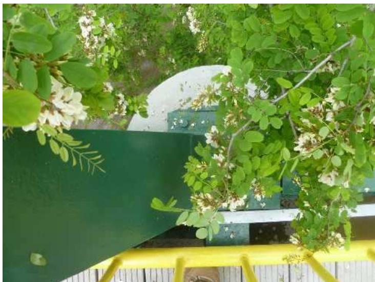
Uložení NK na pilíři 5 v době kulminace Vltavy dne 04.06.2013.
