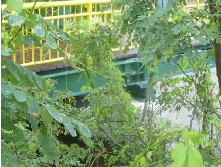
Uložení 5.pole u pilíře 5.
