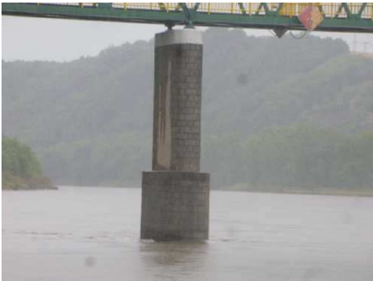
Pohled na pilíř 4.
