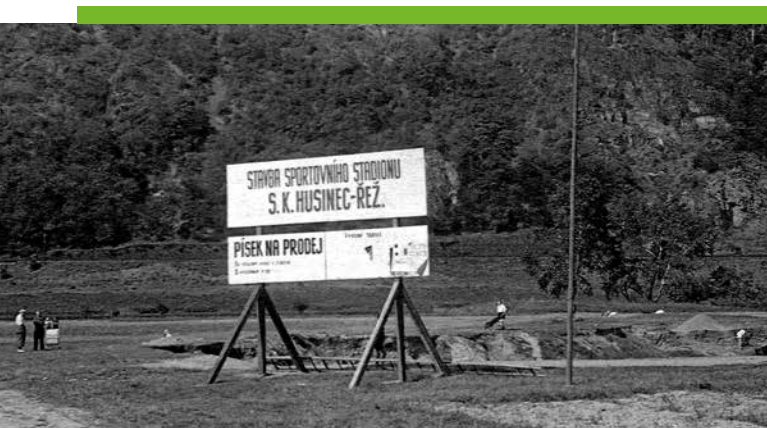
Fotografie ze stavby „stadionu“ v Řeži
