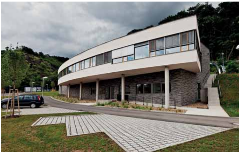
Na moderní budově VaV PET Centra Řež vyrostě třetí nadzemní podlaží se zdravotnickým zázemím pro vyšetřování pacientů.
